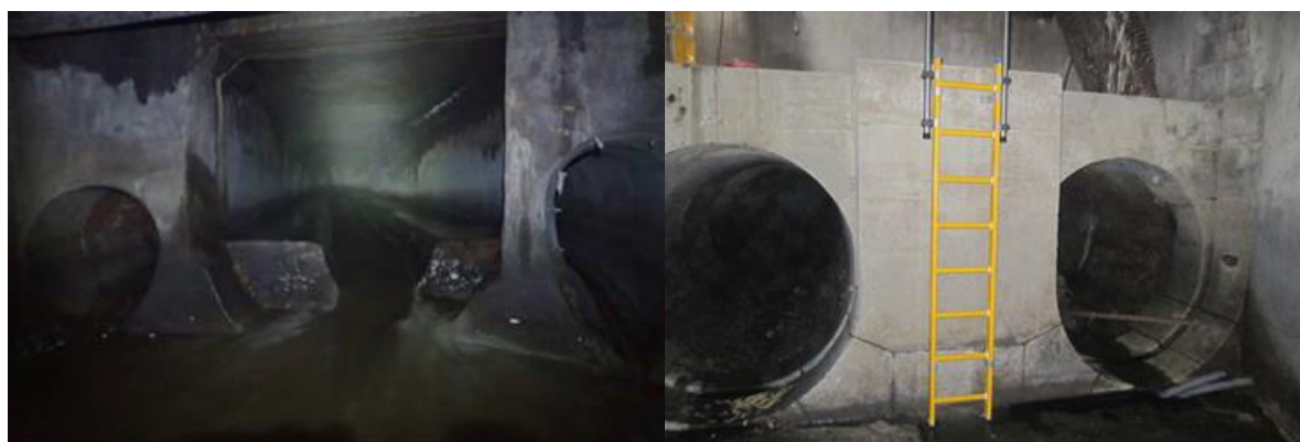
Figuur 52 : Aankomst van de collector van Molenbeek in de inspectieput op de linkeroever
