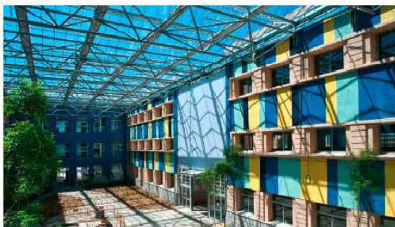
Onderzoekscentrum, Lleida, Pich Aguilera Architects
