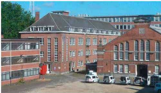
Huidige situatie gebouw
