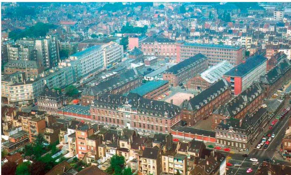
Source : BUUR - vue aérienne du site depuis le sud-est
