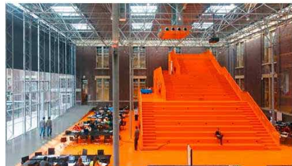
Renovatie Architectuuruniversiteit TU Delft, NL
