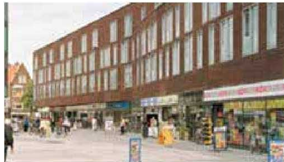
Activering van de benedenverdieping (S333, Groningen, NL)
