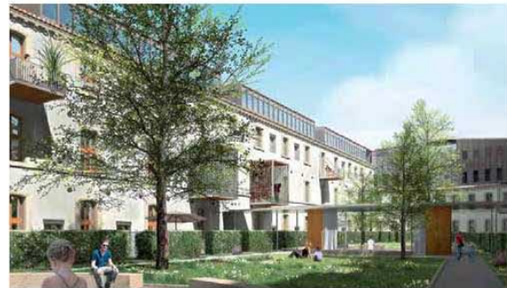
Renovatie van de voormalige gevangenis Saint-Anne, Avignon, FR
