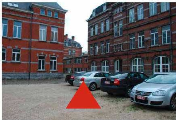
PERCÉE VISUELLE, DEPUIS LE PARVIS
