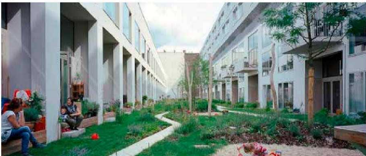
4 Passage entre bâtiments. Référence: zone résidentielle, Berlin, DE (Zanderroth Architekten)
