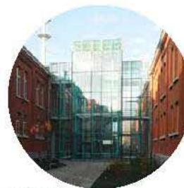
1980-2015 GEBOUW F en G
