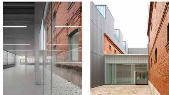
Renovatie van een voormalige gevangenis, burgerlijk centrum, Palencia, ES
