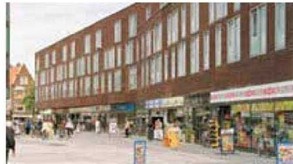
Activation de rez-de-chaussée (S333, Groningen)
