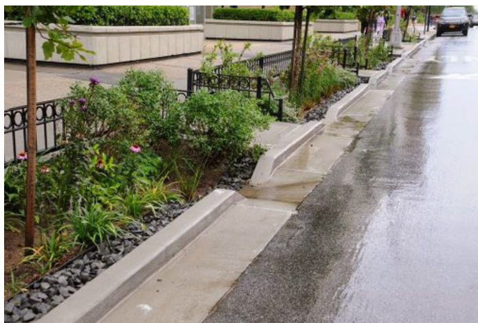
Infiltration d'eau Waterinfiltratie
