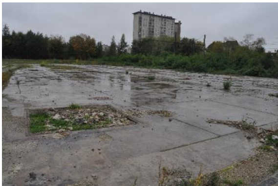
Photo 9 : Zone bétonnée avec stagnation d'eau de pluie, au nord du site (Photo : ABO)
