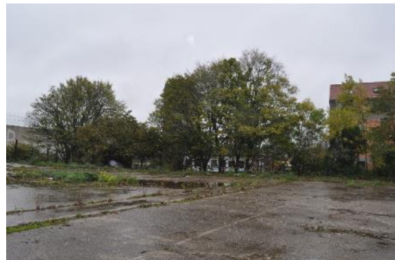
Photo 10 : Zone bétonnée avec stagnation d'eau de pluie, au nord du site (Photo : ABO)
