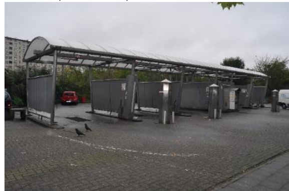
Photo 22 : Carwash (Photo : ABO)
