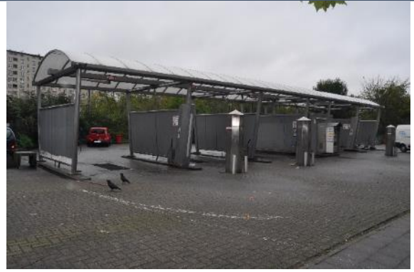
Photo 51 : Carwash (Photo : ABO)
