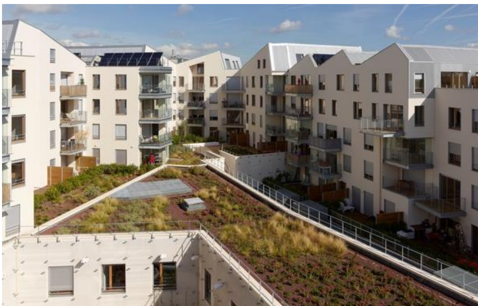
Figure 150 : Îlot Armagnac à Bordeaux (projet ANMA) : 163 logements sociaux et en accession avec un coefficient d'occupation du sol moyen de 3,3 (Source photo : site web du bureau ANMA, photo S. Chalmeau)
