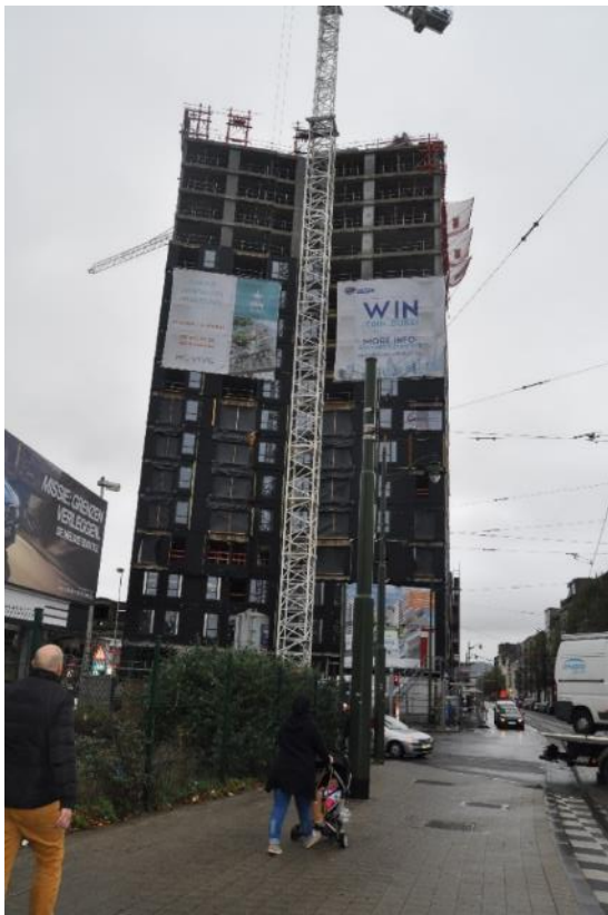
Photo 64 : Tour en pointe d'ilot du projet ECLA. Avancement en date du 24 octobre 2017 (Photo : ABO)
