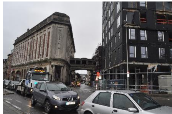
Photo 65 : Raccord entre les brasseries Vandenheuvel et la tour en pointe d'ilot du projet ECLA. Avancement en date du 24 octobre 2017 (Photo : ABO)
