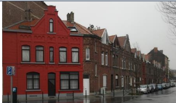
Photo 41 : Ensemble de 22 maisons ouvrières rue Dubois-Thorn (Source: Région de Bruxelles-Capitale: Inventaire du patrimoine architectural)
