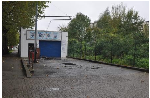
Photo 53 : Carwash (Photo : ABO)
