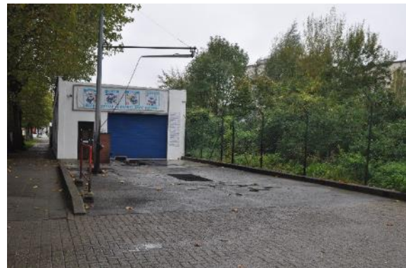
Photo 63 : Carwash (Photo : ABO)
