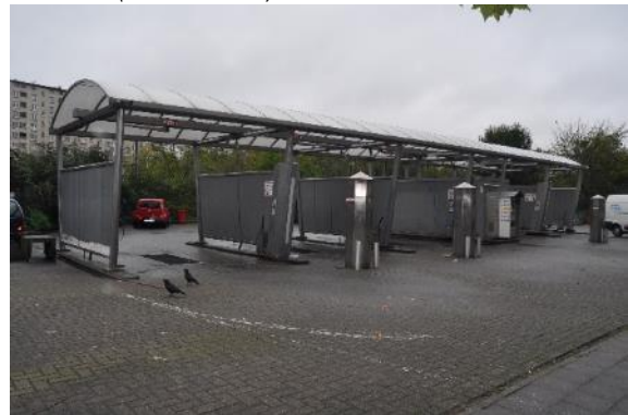
Photo 13 : Carwash (Photo : ABO)
