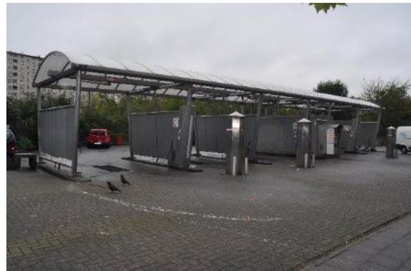
Photo 61 : Carwash (Photo : ABO)
