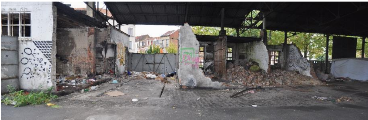
Photo 27 : Locaux en ruine dans la halle aux charbons (Photo : ABO)
