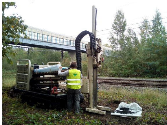
Figure 60 : Réalisation de forages mécaniques à l'aide d'une Geoprobe
