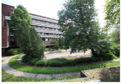
Huidige situatie - Niet-gebruikte waterplant
