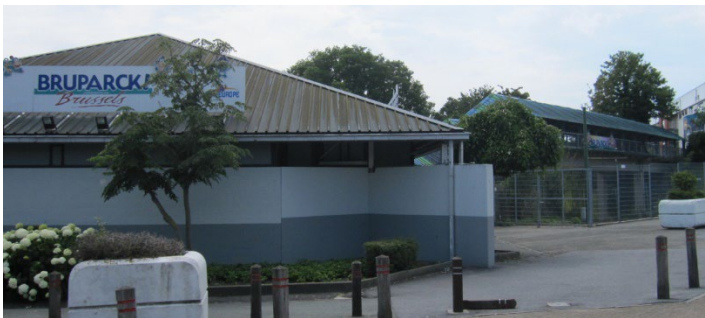
Zicht op de voetgangersbrug vanaf parking T (ARIES, 2020)
