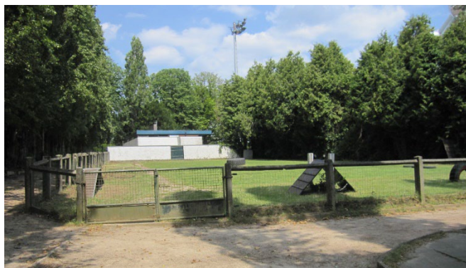
Zicht op het gebouw van de kleedkamers en het sanitair, voorafgegaan door het terrein voor het africhten van honden (ARIES, 2020)
