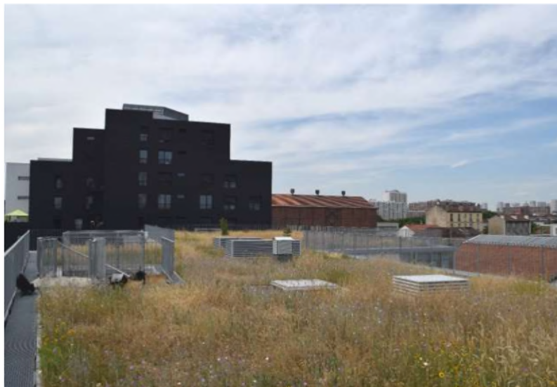
Figuur 145: Voorbeeld van een semi-intensief dak - Rosalind Franklin School, Ivry-sur-Seine (Hemminki Johan, 2018)
