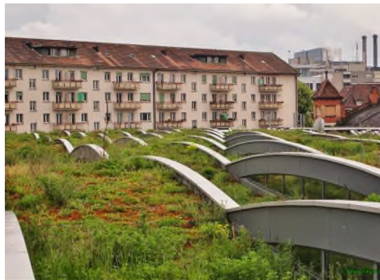
Figuur 148: Groendak van de tramremise van de stad Bazel - Een innovatief project: een lichte constructie met een drainagelaag van 10 cm van miscanthusstro ( http://naturetoit.blogspot.com/2014/07/le-wiesenteppich-de-bale.html )
