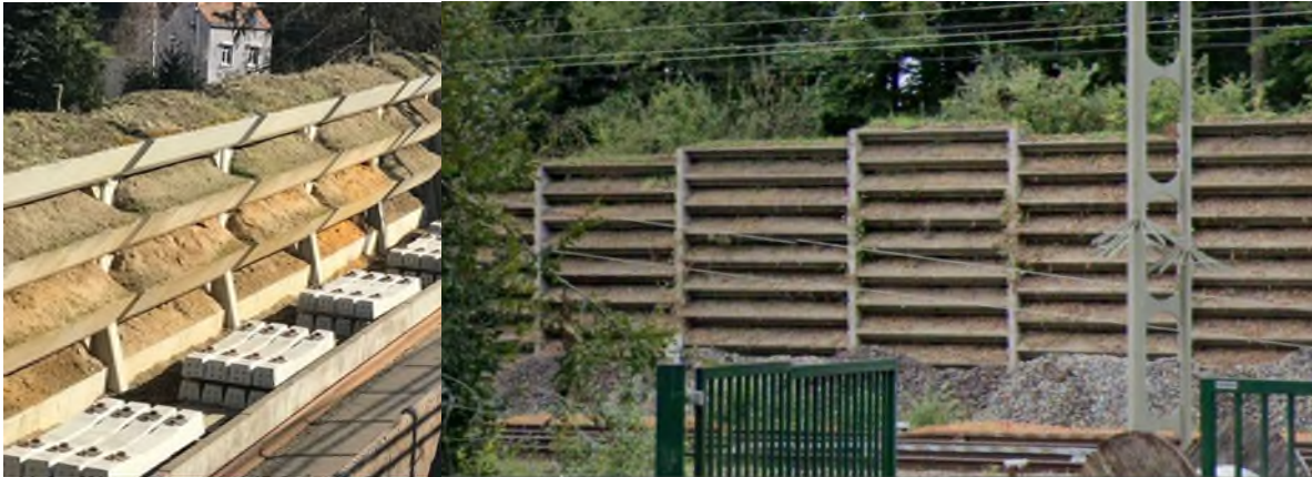
Afbeelding 64: Voorbeeld van geluidsscherm dat voor het Brusselse GEN werd gebouwd (INFRABEL.be)
