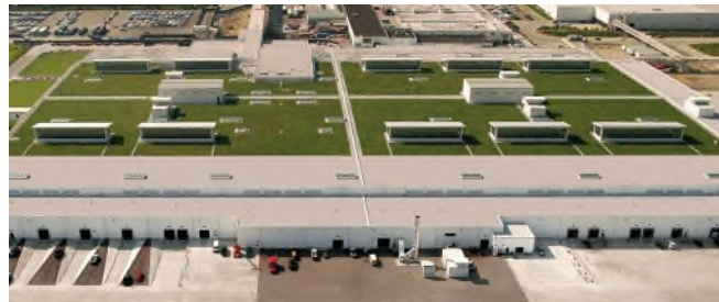
Figuur 147: Voorbeeld van een groendak op een lichte structuur - Ford Motor Company's River Rouge Truck Plant ( www.greenroofs.com )
