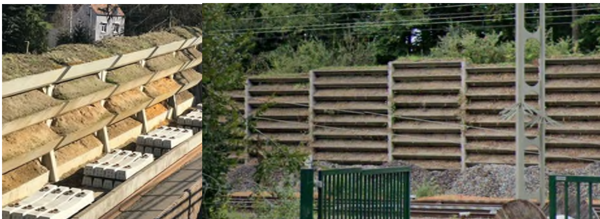
Figuur 149: Voorbeeld van een geluidsscherm gebouwd voor het Brusselse GEN (INFRABEL.be)
