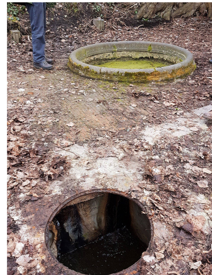
La source finit sa course dans le réseau d'égouttage Photo : asbl Coordination Senne
