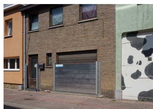
Barrages contre les inondations
