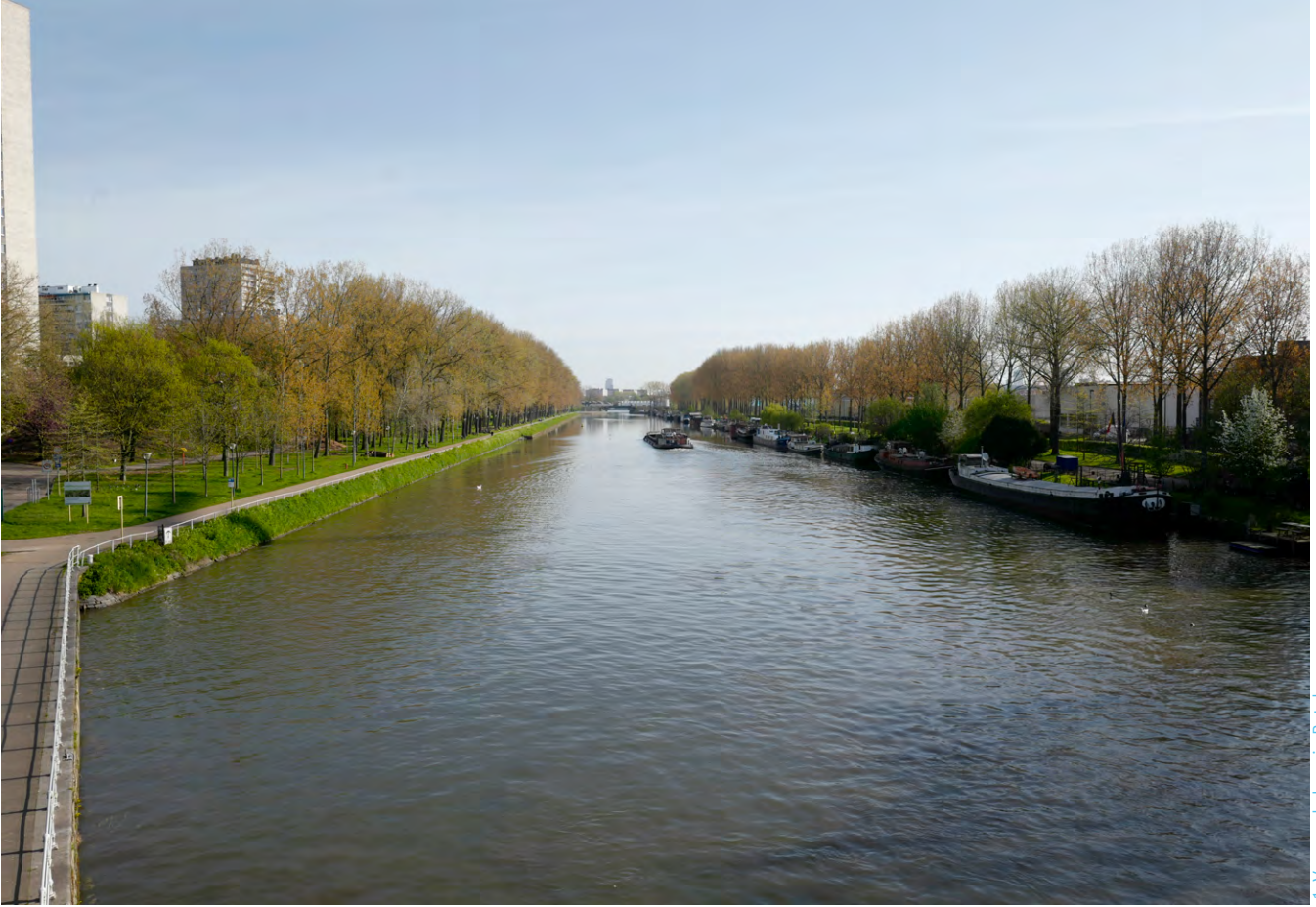
1. Vue sur le bassin Batelage
