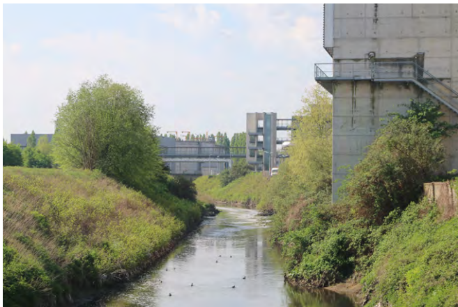
La Senne à ciel ouvert au nord
