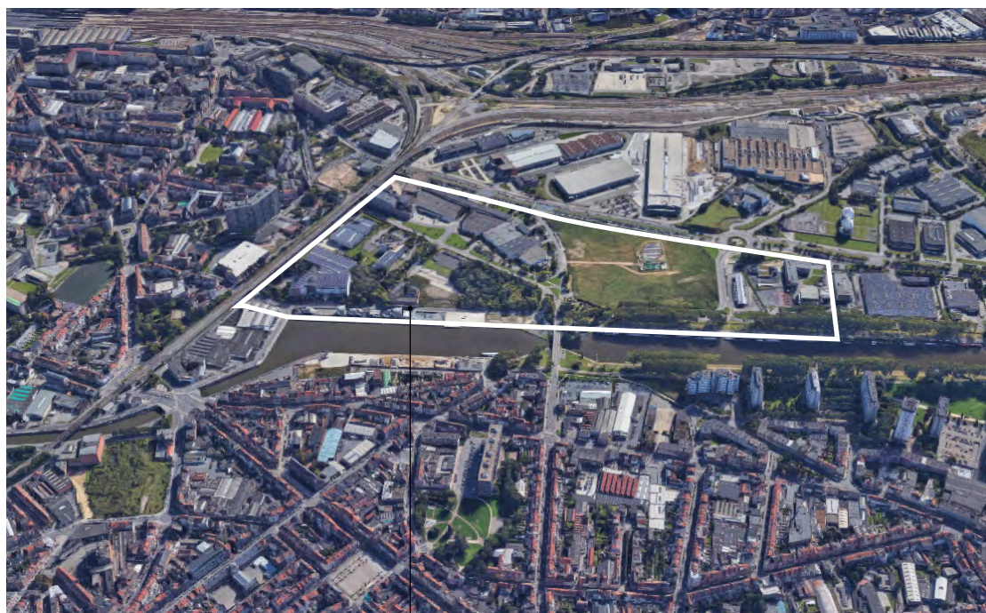
Zone de la rive droite appelée à connaître une profonde mutation
