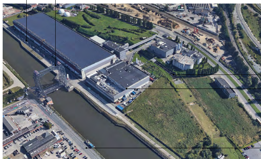
Digue du Canal Pont de Buda
