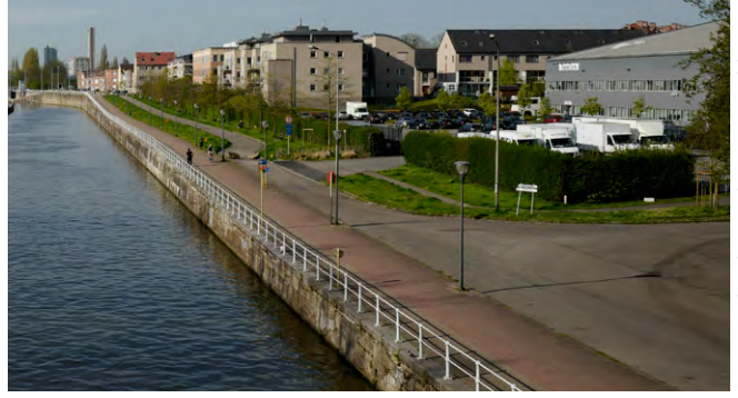
Rive gauche du canal, espace public non aménagé
