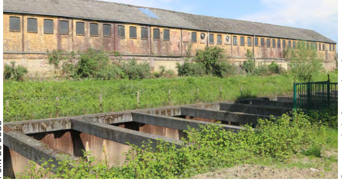
Passage de la Senne dans la zone
