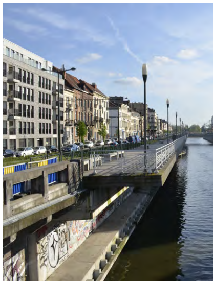
10. Rive urbaine à encorbellement en béton
