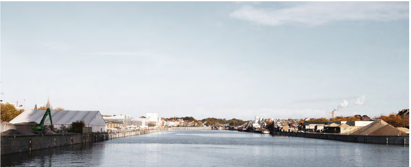
5. Vue du Bassin Vergote vers le nord
